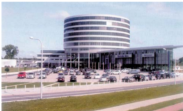
Rys. 6. Zautomatyzowany budynek salonu Mercedesa w Alejach Jerozolimskich w Warszawie z 3000 węzłów sieci LonWorks
