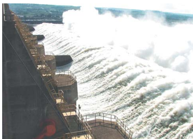
Hydroelektrownia na rzece Tocantins
