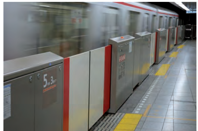
Rys. 2. Przesuwne półściany w metrze w Tokio
