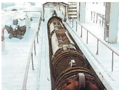
Rys. 7. Kapsuły systemu Transprogress opracowanego w 80. latach w byłym ZSRR [www.capsu.org]
