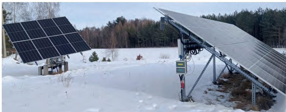
Rys. 1. Badane instalacje PV: nadążna (po lewej stronie) i stacjonarna (po prawej stronie)
