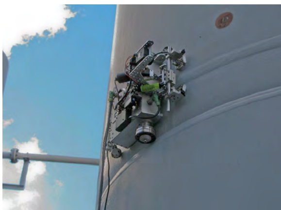
Rys. 8. Robot na instalacji przemysłowej
